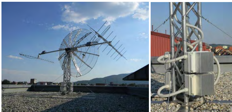
Slika 1: Antenski sistem programsko definirane zemeljske postaje za frekvenčna področja VHF, UHF in S (levo), in pripadajoči ojačevalni elementi (desno).
